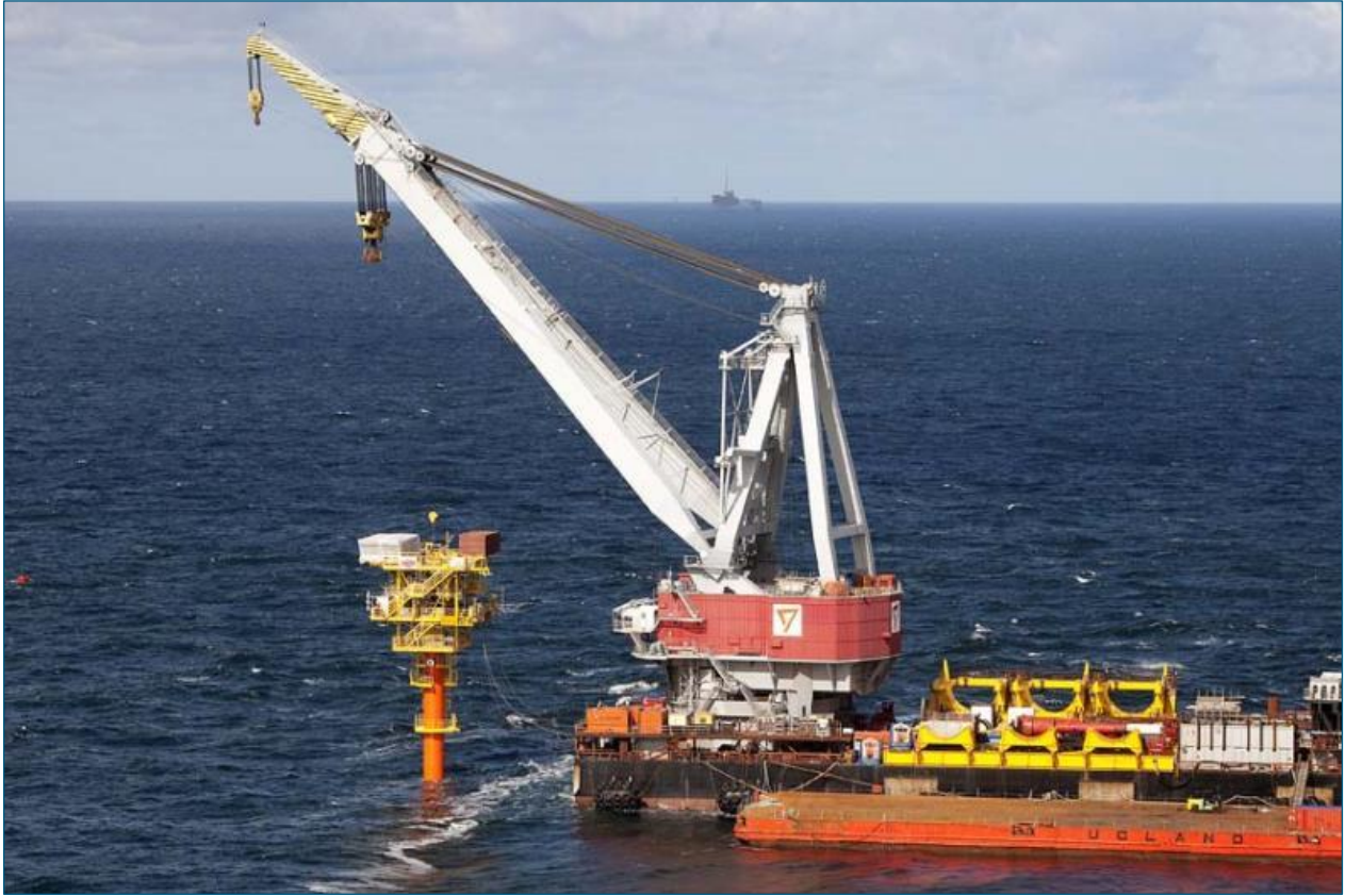
Figuur 5: Plaatsing van een satellietplatform met behulp van een kraanschip. (© Foto & Video Honing)
