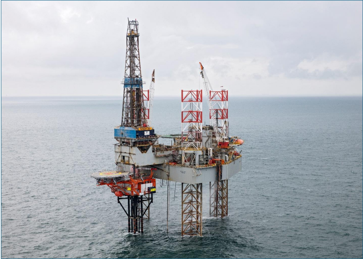
Figuur 6: Een boorplatform (rechts) dat deels boven een gaswinningsplatform (links) is geplaatst. (© Foto & Video Honing)
